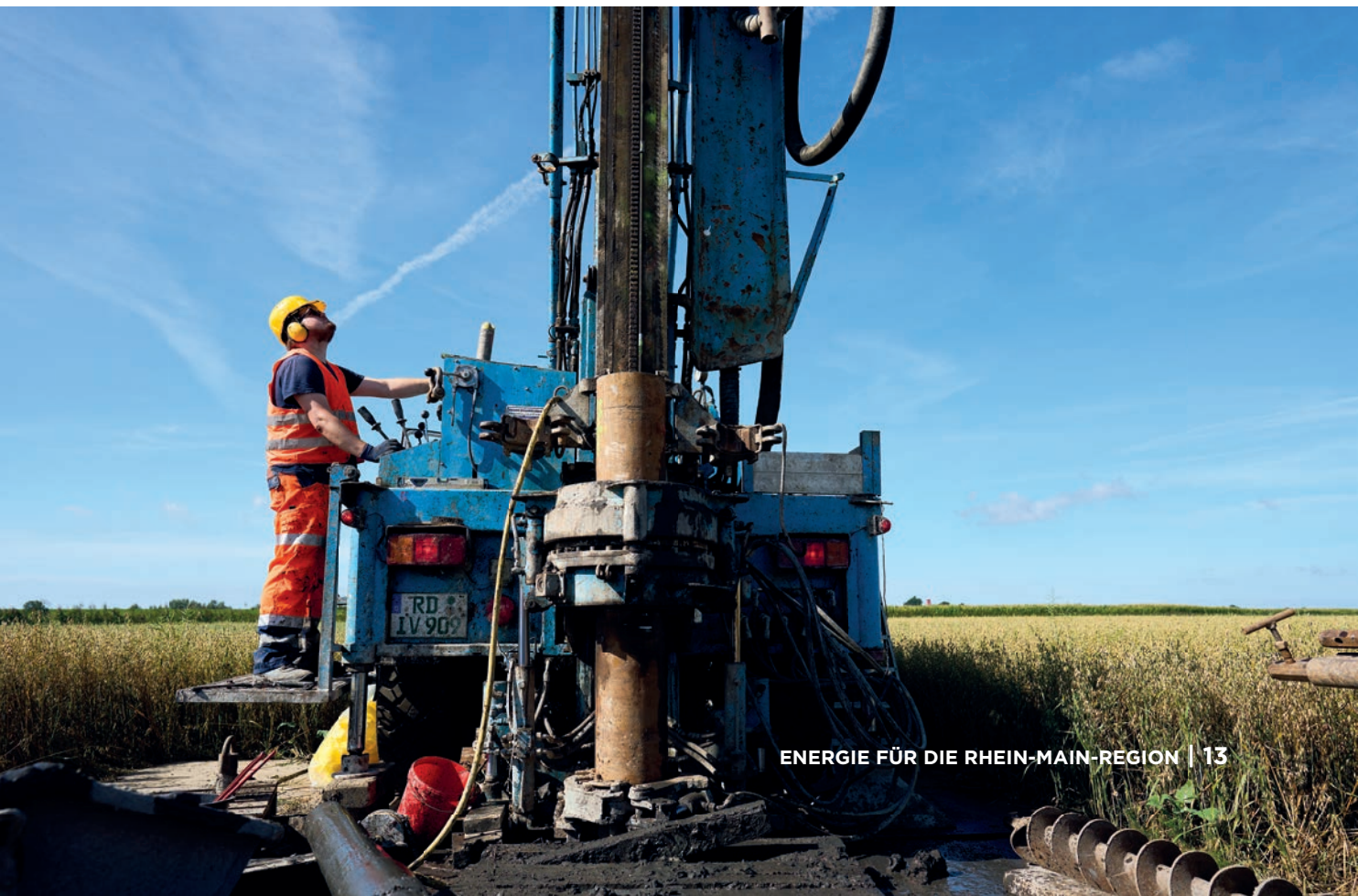
Durchführung einer Bodengrunduntersuchung des Projekts Korridor B
