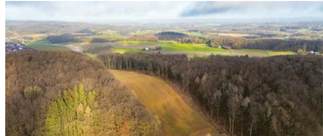
Abbildung des Amprion Erdkabelprojektes EnLAG16 (Wechselstrom-Erdkabelprojekt mit 18 Kabeln) in offener Bauweise. Der sichtbare Streifen ist rund 50 Meter breit. EnLAG = Energieleitungsausbaugesetz
