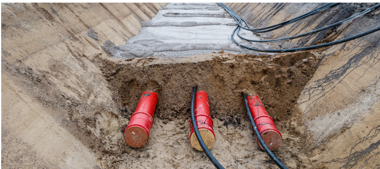
Eine Erdkabelbaustelle für das Gleichstromprojekt A-Nord. Beim Rhein-Main-Link sollen ebenfalls drei Stromkabel pro Graben verlegt werden. Quelle: Tobias Meinhardt, IPA
